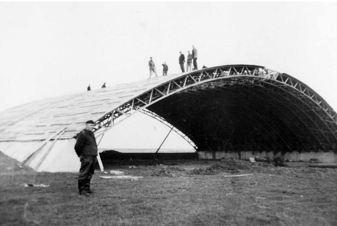
Flugzeughalle Fieseler Kassel, 1939
